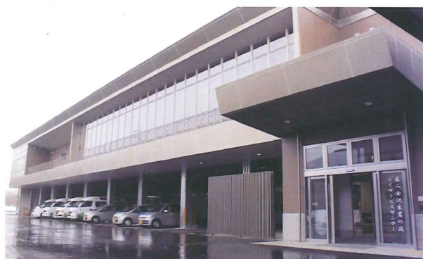
工事が完了した 第二金沢朱鷺の 苑デイサービス センター
